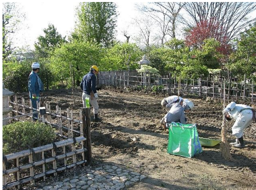
初日は4年前に施工した庭を取り壊し、更地にします
