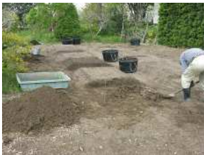
① 堆肥区の土を撤去している状態
