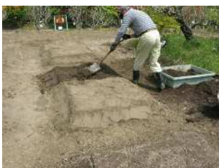
④ 混合土を戻している状況
