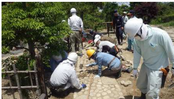
写真⑤【延段の設置】
