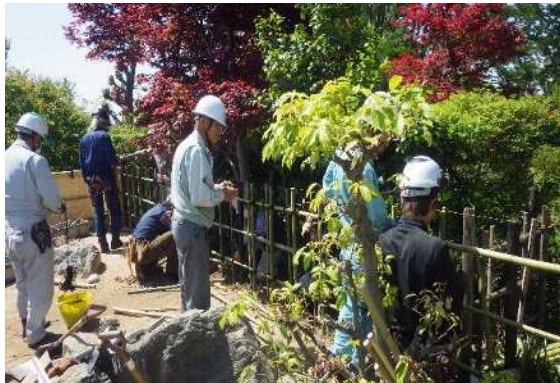
写真③【竹垣の設置】
