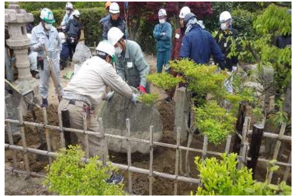
写真④【石の設置】
