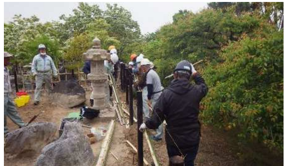
写真②【親柱・間柱の建て込み等】
